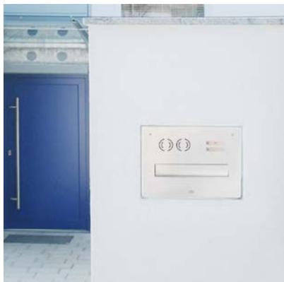
Bei der Mauerdurchwurf-Montage wird der Briefkasten in einen Mauerdurchbruch eingebaut.
