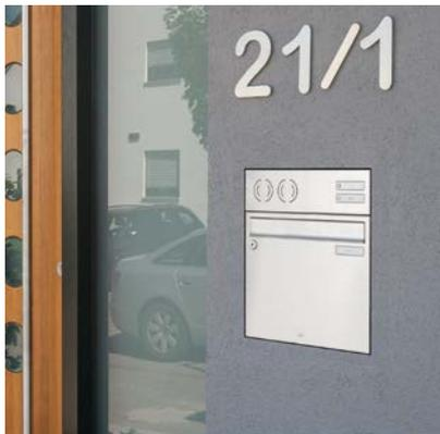
Bei der Unterputz-Montage wird die Briefkastenanlage in einer Mauerausparung versenkt eingebaut.
